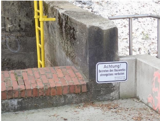
Höhenabstand zwischen altem Tosbecken und Überlaufbauwerk.
