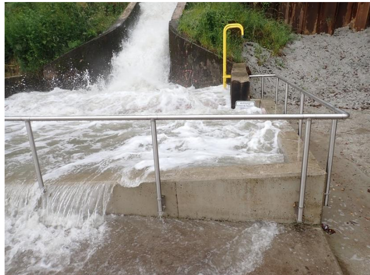
Nach mittlerem Regen. Das Wasser im Becken bewegt sich turbulent, erste Wellenkämme schlagen über die Seitenwand.
