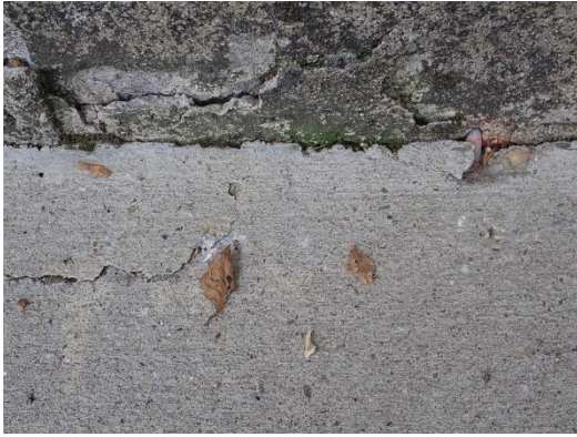
Abplatzungen und Spaltbildung zwischen den Bauwerken (links), Setzungsbewegung (rechts)
