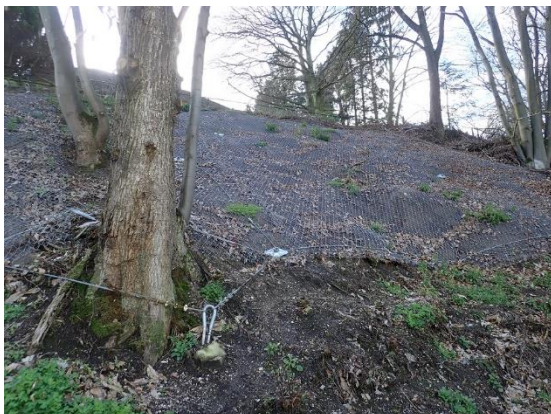
Oberflächensicherung: Geotextil, Maschendraht, Stahlseile, Erdnägel
